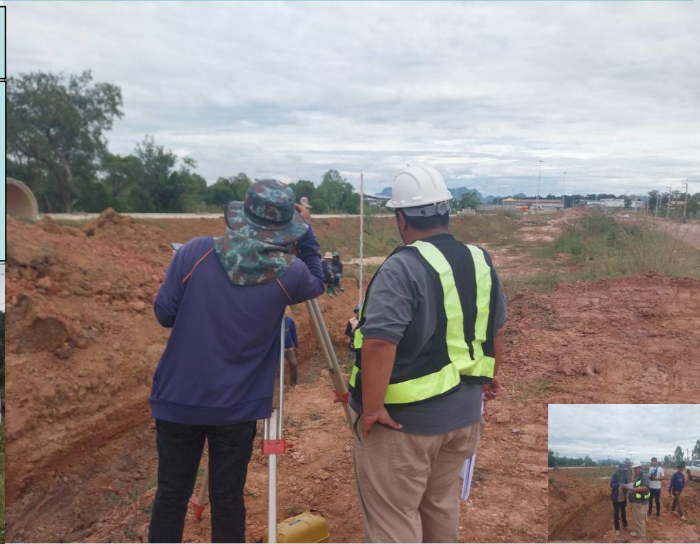
ตรวจแนวและระดับ ก่อน เทลีน งาน box culvert กม.ที่ ๑๔+๗๖๐ และกม.ที่ ๑๕+๑๕๐ ตอนที่ ๑
