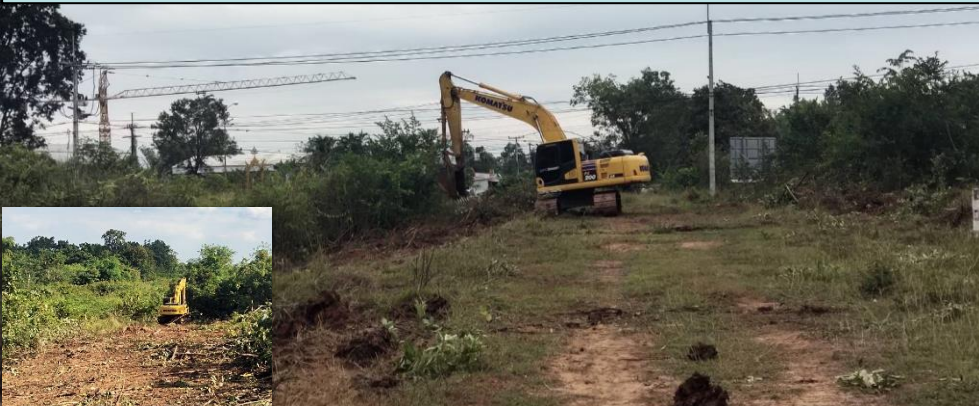
งานถางป่าและขุดตอ ขนาดกลาง กม.ที่ ๐+๐๕๐ - ๑+๕๐๐ ตอน ที่ ๑
